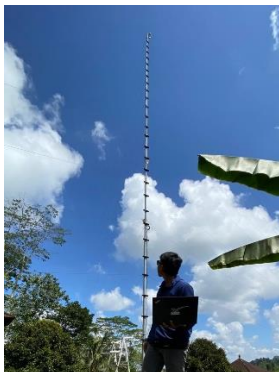
Gambar 6. Pemasangan Perangkat Client
