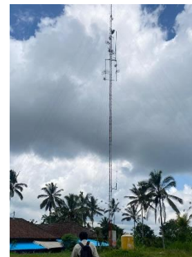
Gambar 7. Pemasangan Perangkat BTS
